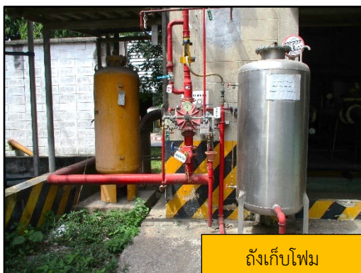
ภาพที่ 2.60 ระบบดับเพลิงบริเวณพื้นที่กักเก็บของเสียที่เป็นของเหลว
