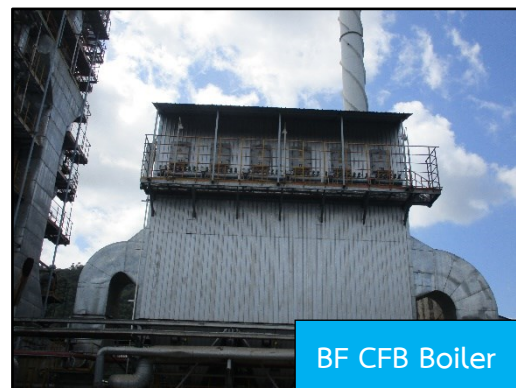
ภาพที่ 2.1 อุปกรณ์ดักฝุ่นแบบถุงกรอง (BF)
