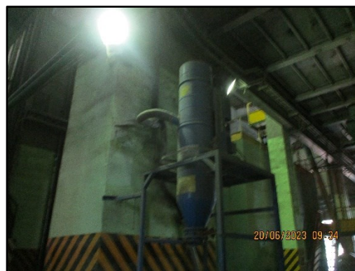
ภาพที่ 2.45 อุปกรณ์ดูดฝุ่นแบบสูญญากาศบริเวณพื้นที่ที่มีฝุ่นมากภายในอาคาร
