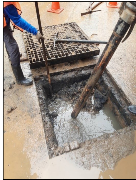
ภาพที่ 2.40 การขุดลอกรางระบายน้ำ
