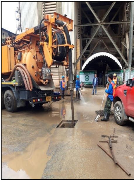
ภาพที่ 2.40 การขุดลอกรางระบายน้ำ
