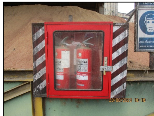
ภาพที่ 2.58 การติดตั้งถังดับเพลิงแบบมือถือบริเวณพื้นที่จัดเก็บ Biomass
